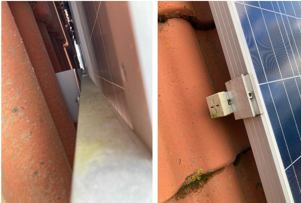
Bild 8. Exempel på infästningsanordningar för solcellspaneler på tak med pannor. Fotograf: Jan-Olof Cleve.
