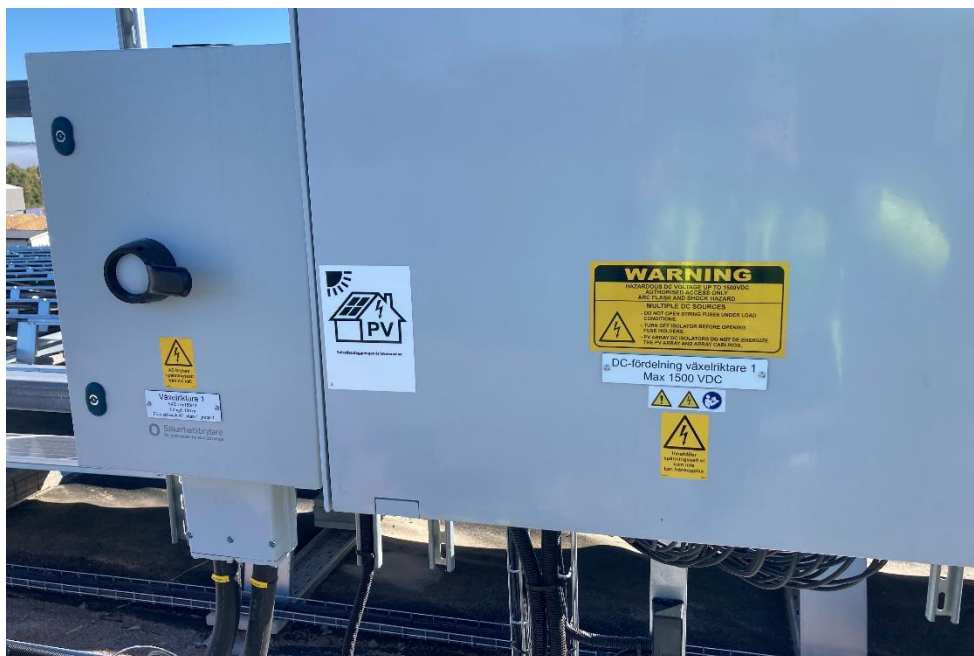
Bild 9. Exempel på kopplingsbox (till höger). Fotograf: Jan-Olof Cleve.
