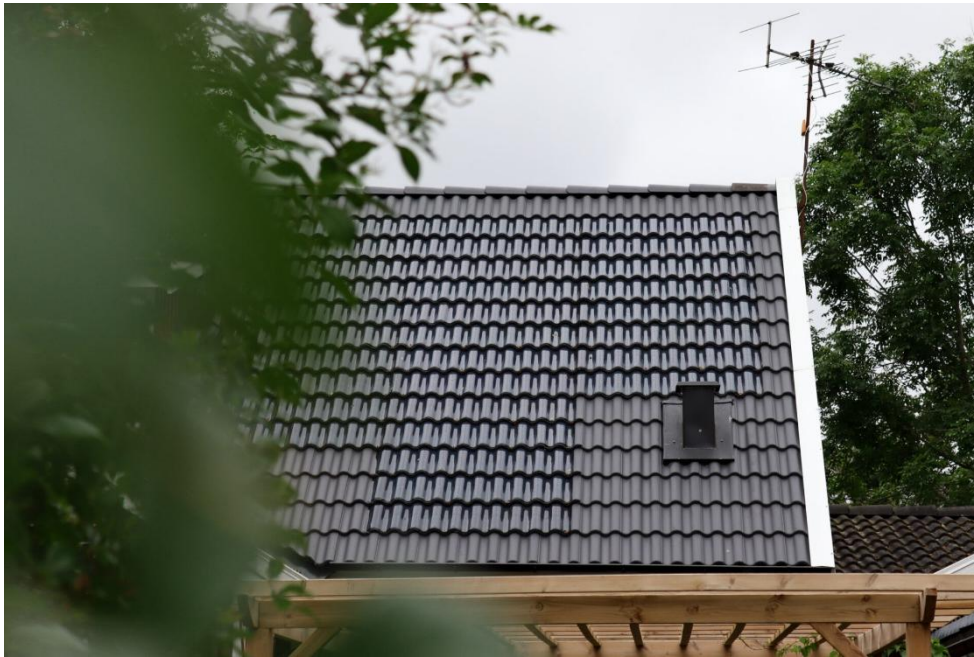
Bild 5. Exempel på byggnadsintegrerade solcellsmoduler i form av tunnfilm på takpannor. Fotograf: Midsummer Wave.
