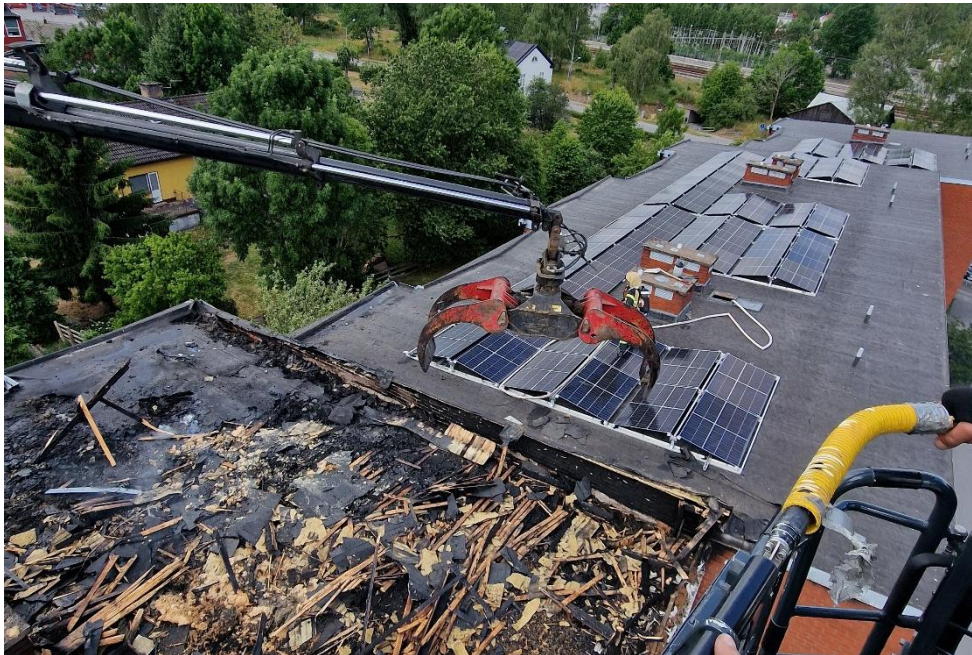
Bild 21. Exempel på lyft av solcellsmoduler med gripklo. Fotograf: Johan Engström.
