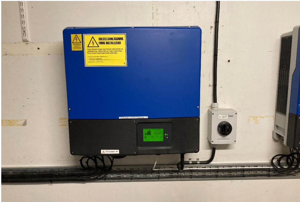
Bild 10. Exempel på växelriktare. Fotograf: Jan-Olof Cleve.
