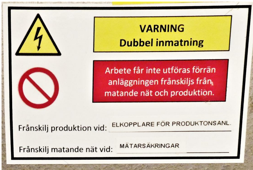
Bild 15. Exempel på varningsskylt för dubbel inmatning. Fotograf: Myndigheten för civilt försvar.
