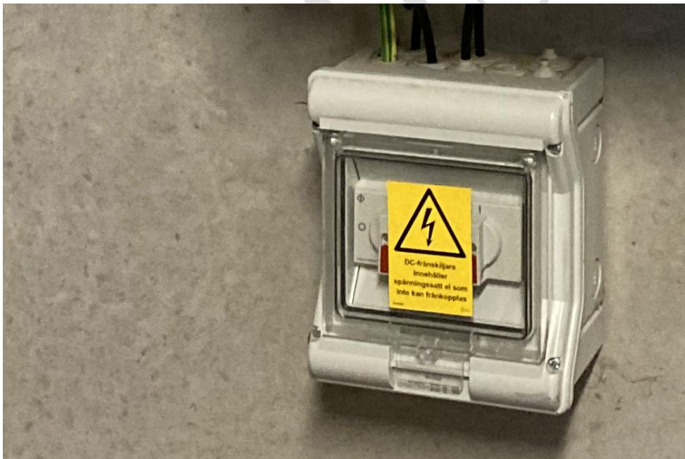
Bild 13. Exempel på separat likströmbrytare i anslutning till växelriktare. Fotograf: Jan-Olof Cleve.
