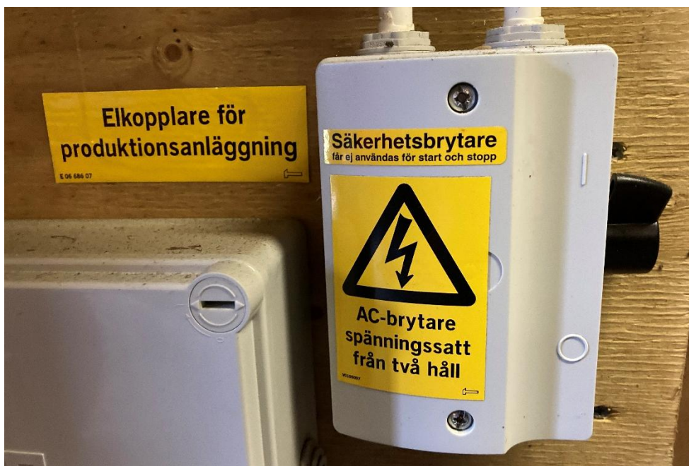
Bild 11. Exempel på växelströmbrytare vid växelriktaren. Fotograf: Jan-Olof Cleve.
