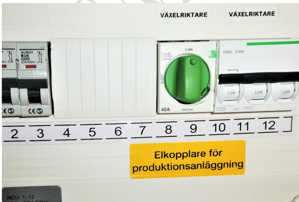
Bild 16. Exempel på märkning för elkopplare för produktionsanläggning. Fotograf: Myndigheten för civilt försvar.
